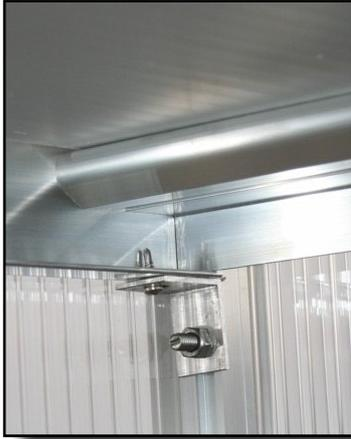
Montieren Sie den Winkel mit einer Hammerkopfschraube M6 x 16 (S15) an die Randsprosse. Legen Sie dann die Pflanzwanne auf dem Winkel auf und verbinden beides mit einer Bohrschraube 3,5 x 13 (S) miteinander.
