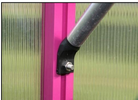
Wanne an den Gewächshausprossen verschrauben. Hierzu die Streben (Pos. 3) an den Sprossen anschrauben. Verwenden Sie an den Randsprossen bitte Hammerkopfschrauben M6 x 16 (S15).
